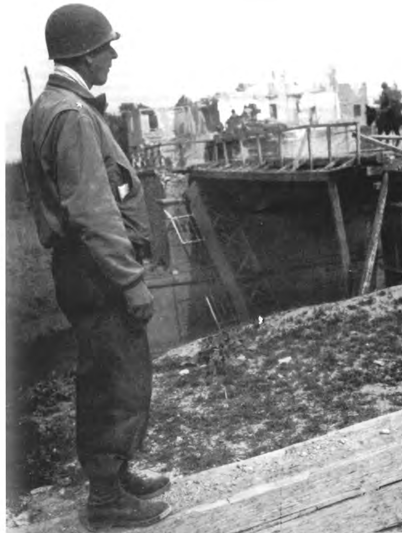
Da notare, il ponte puntellato; il parapetto improvvisato è di legno, appoggiato ad un pilone un trave di sostegno di ferro caduto in acqua. Sul ponte un carrarmato, un soldato a cavallo. Sullo sfondo, la distruzione totale della casa e dell'osteria De Maria - Fiorini
